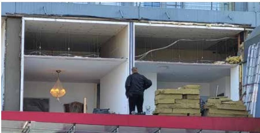
Der Teilbereich wurde energetisch saniert. Die neue Fassade ist deutlich besser gedämmt, neue Fenster und Heizkörper wurden eingesetzt.
